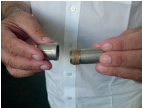
Gewinde einhanfen Enrober le filetage avec du chanvre Rivestire la filettatura canapa
